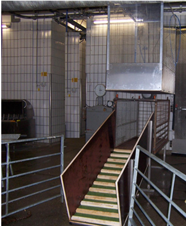
Abbildung 4: Die Helium-Betäubungsanlage im Notschlachtraum
